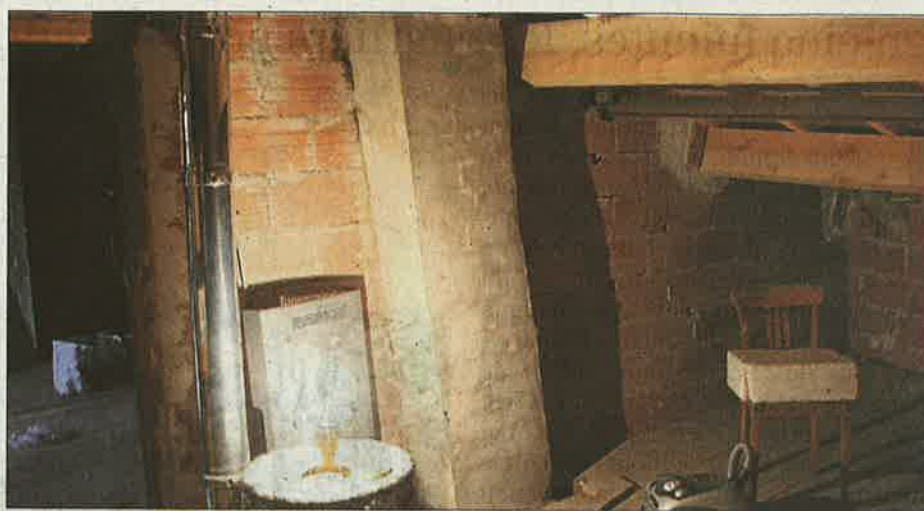
■ Pose d'un poêle à pellets dans le couloir et isolation du plafond pour être mieux chauffé.
